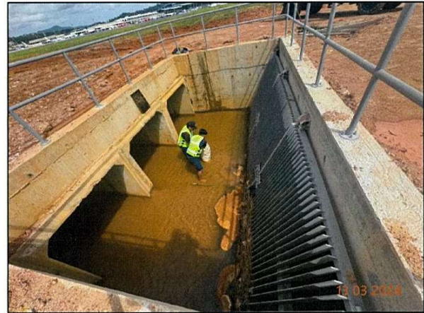
ภาพถ่ายที่ 2.3-12 การขุดลอกรางระบายน้ำแนวที่ 1 ภายใน ทกภ.
