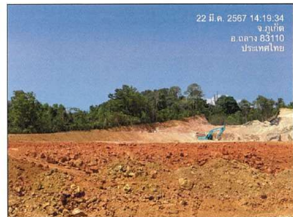
ภาพถ่ายที่ 2.3-10 การปรับความลาดเอียงของงานขุด/งานตัดดิน
