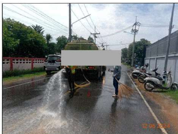
ภาพถ่ายที่ 2.3-6 เจ้าหน้าที่ทำความสะอาดพื้นที่ล้างล้อรถ พื้นที่ก่อสร้าง และถนนที่ใช้ในการสัญจร
